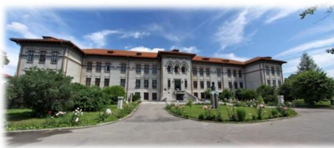
Clădirea Muzeului Regiunii Porților de Fier
