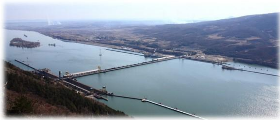
Hidrocentrala de la Porțile de Fier I – vedere generală
